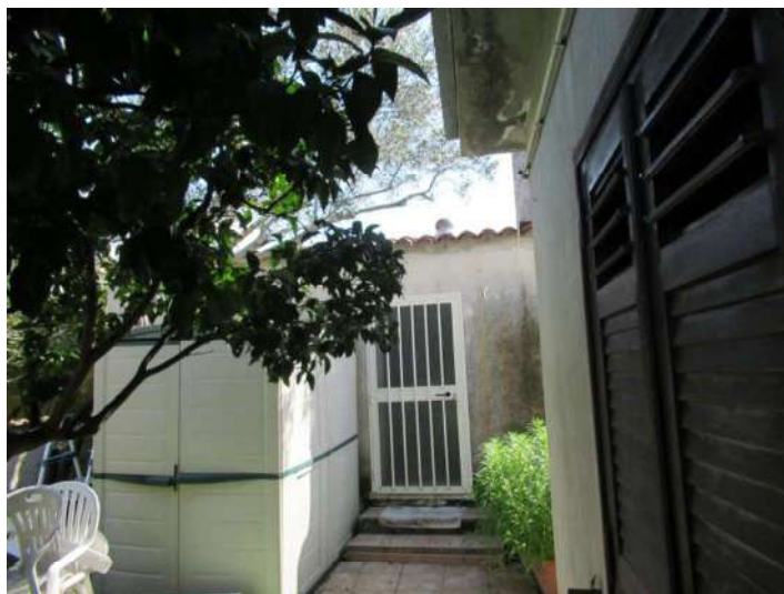
VISTE ETERNE LATO CUCINA E LOCALE DEPOSITO
